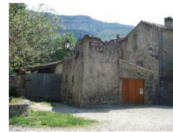
Le bâtiment acheté par la commune de Saint-Maurice-Navacelles
