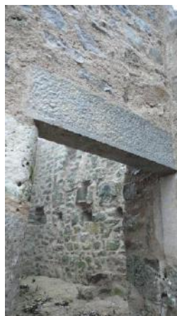
Travaux de stabilisation
