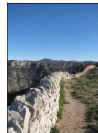
Environ 100 mètres de muret rénové
